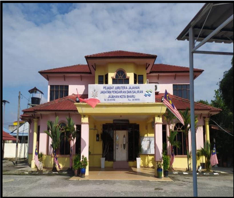
Bangunan JPS Kota Bharu
